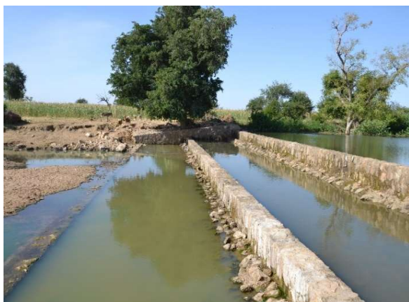
Seuil d'épandage, © GIZ- Equipe GERTS
