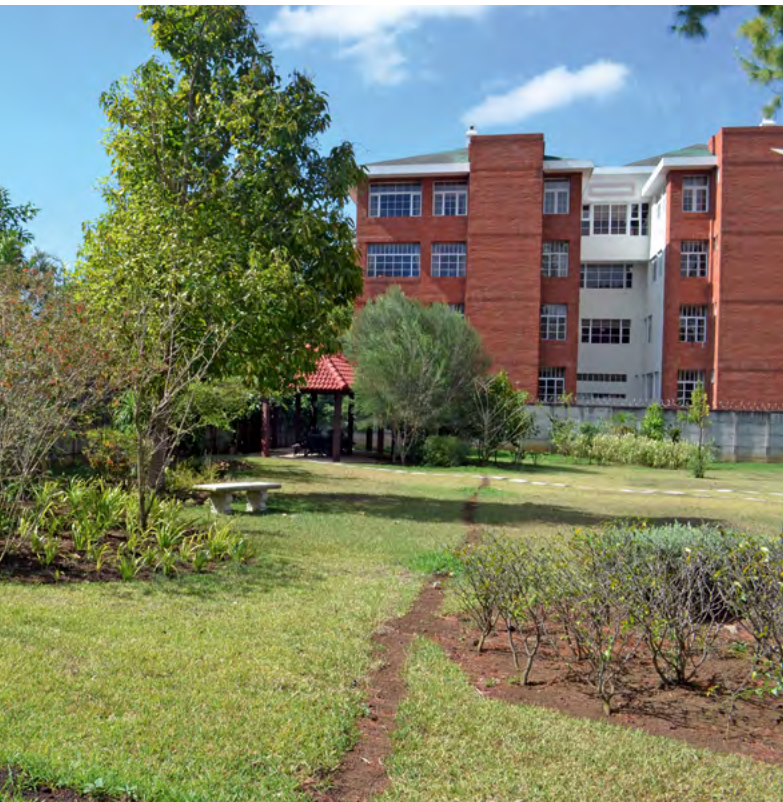
Unterflurbewässerung im Biogarten, GIZ Büro, Guatemala.
