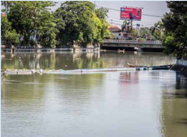
Floating barrier, Sidoarjo
