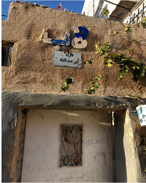
الشكل رقم 39 : صورة لآفة منزل حددت أصحاب المنازل كجزء من مبادرة جماعة لسكان الحارة
