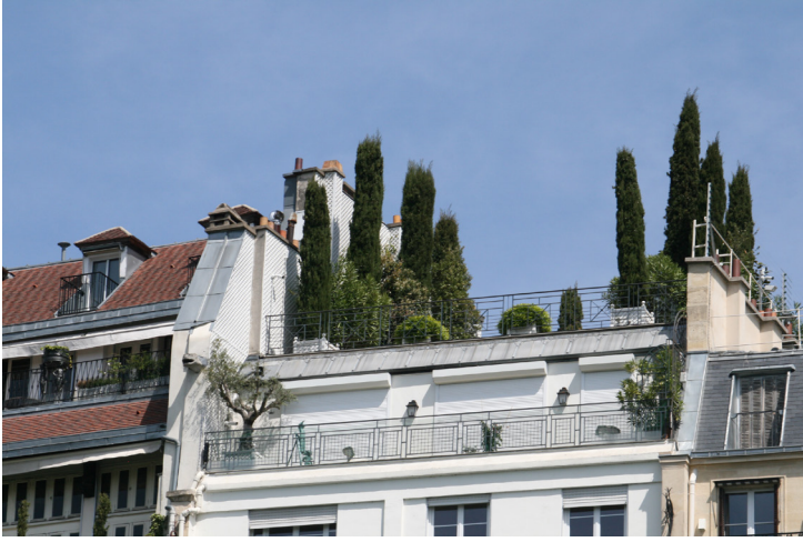
الشكل رقم 15 : سطح أخضر على أحد المباني الباريسية العديدة
