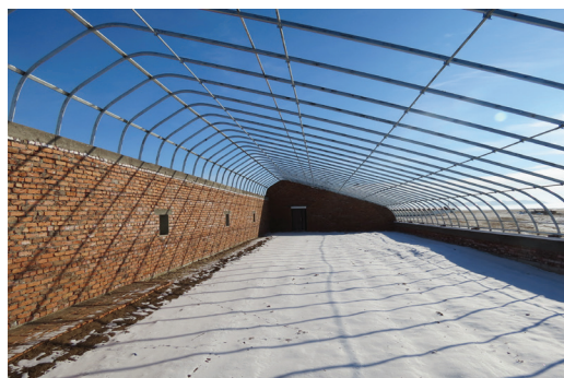
Зураг 37: Хойд болон урд дээврийн карказны суурилуулалт
