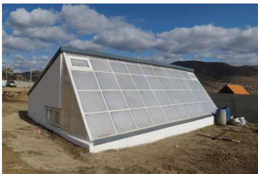
Зураг 2: Газрын өнгөн үеийн дулаан ашигласан пассив хүлэмж
