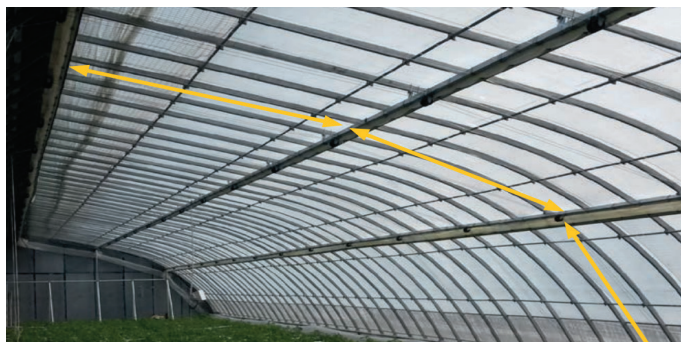
Зураг 41: Хөдөлгөөнт дэлгэц нь нэг мотороор нээгдэж, хаагддаг гурван тэнцүү хэсгээс бүрддэг
