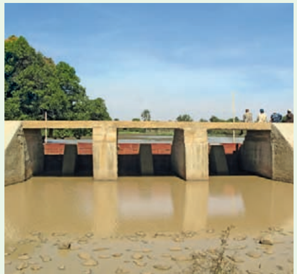
Mit deutscher Unterstützung gebauter Kleinstaudamm in Mali
