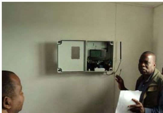
Instalación de equipos
