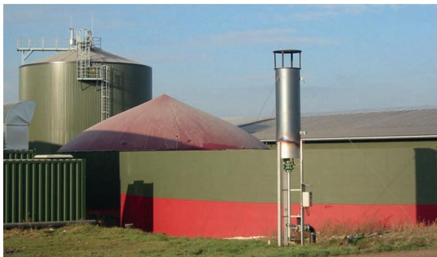
Газовые факелы обеспечивают безопасный выпуск избыточного давления.
