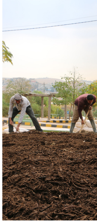
وتجهيز الموقع هندسة التربة Soil Engineering & Mound Making
