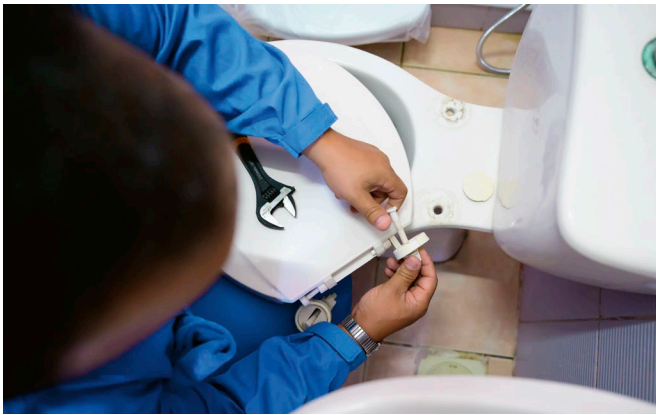
Klempnerschulung in einem Waisenhaus in Jordanien
