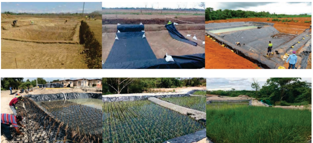
Figura 4: Resumen de las distintas fases de construcción. Movimiento de tierra, instalación del geotextil, instalación de la geomembrana impermeable, así como siembra de plantas, puesta en marcha y humedal flotante plenamente operativo.
