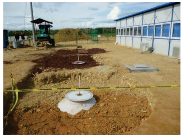
Figura 4: Utilizando plástico reforzado con fibra prefabricada u hormigón monolítico (unas 500 personas para este edificio de oficinas en Miramar) el tiempo de instalación puede reducirse a 3 días.
