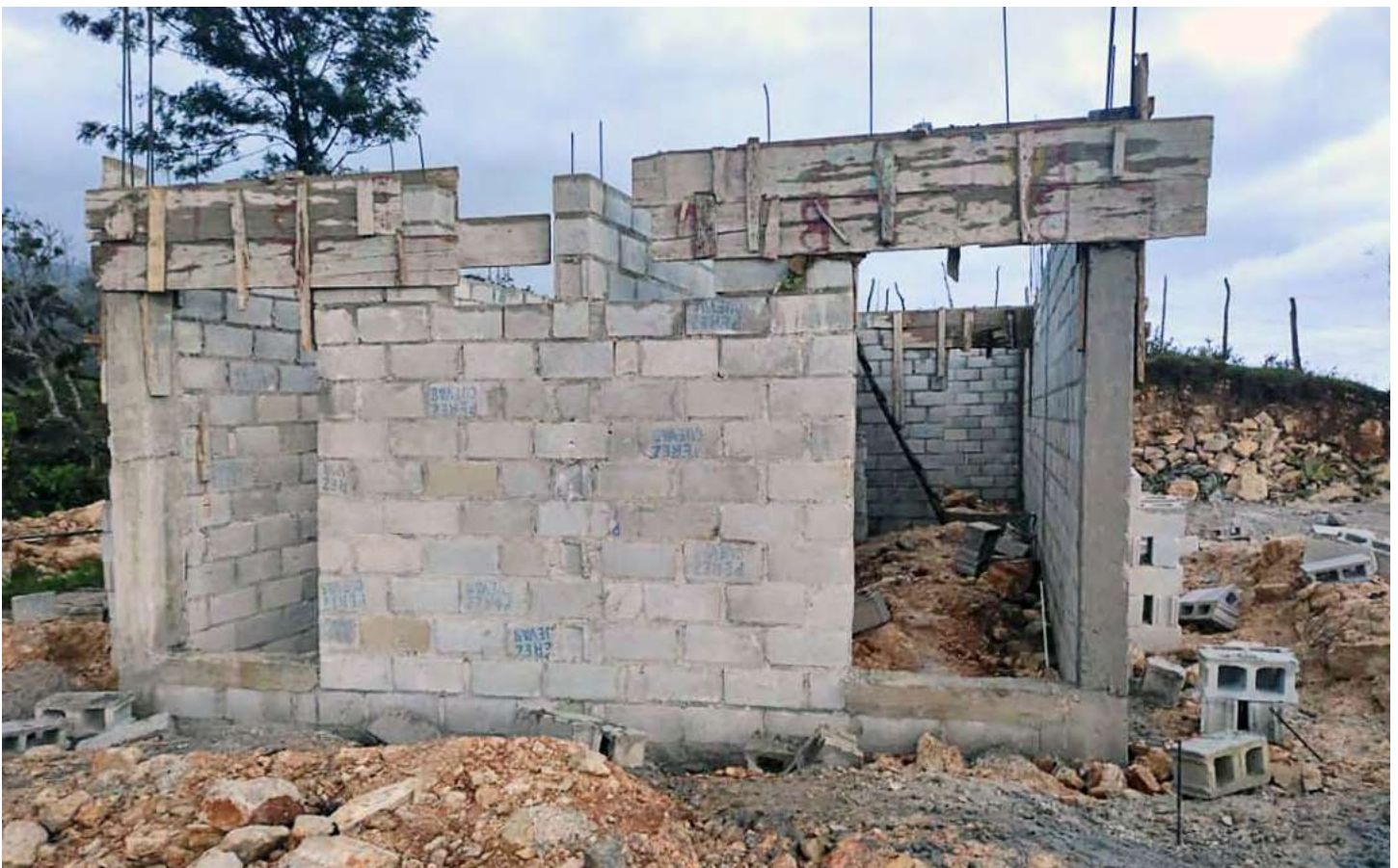
Cuarto de máquinas de la microcentral fotovoltaica en construcción.
