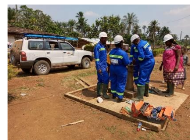
Praktische Ausbildung von GemeindearbeiterInnen in der Wartung einer Wasserstelle
