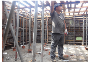
Зураг 16. Төмөр бетонон дээврийн каркас, тулаас зангидах
