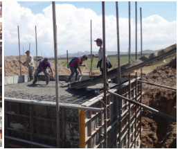
Зураг 17. Дээврийн бетон цутгалтын үед төмөр гулсуур ашиглах
