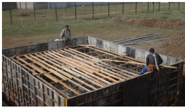
Зураг 16. Төмөр бетонон дээврийн каркас, тулаас зангидах
