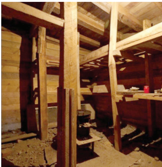
Зураг 6. Хагас ухмал зооринд температур нэмэгдүүлэх зуух байршуулах
