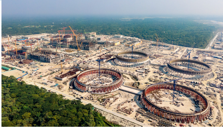
Bau des Rooppur Atomkraftwerks in Ishwardi: Bangladesch setzt bei der Energieversorgung auch auf die Kernkraft.
