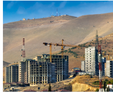
Links: Ein Arbeiter schneidet Metall mithilfe einer Lötlampe Rechts: Gebäudebau in Sulaymaniyah
